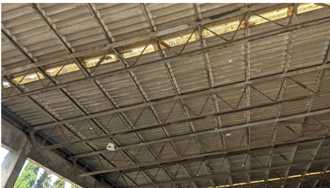
Zgrada 1 - čelična krovna rešetka
