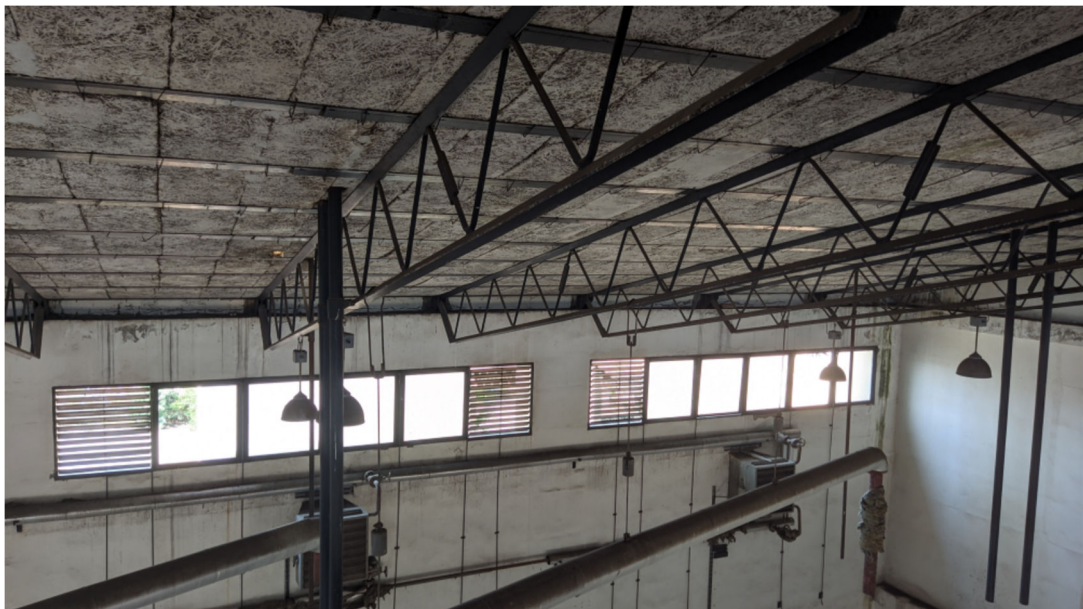
Pozicije 2 - čelične rešetke na većem rasponu krova
