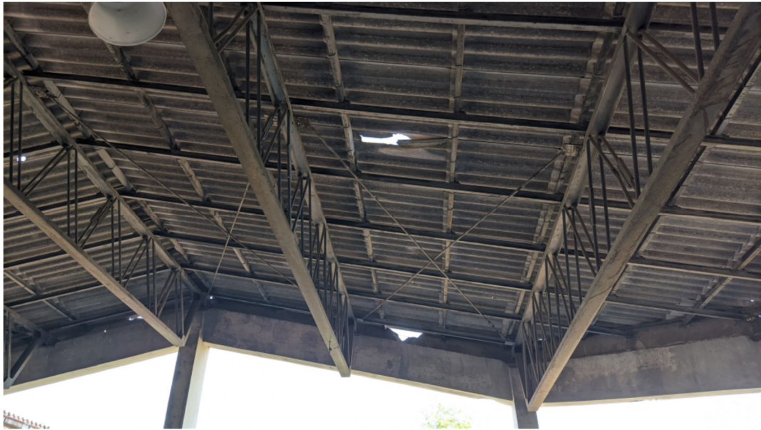
Zgrada 1 - čelična krovna rešetka uz zgradu 2
