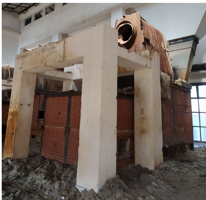
Zgrada 2 - stupovi za kotlove
