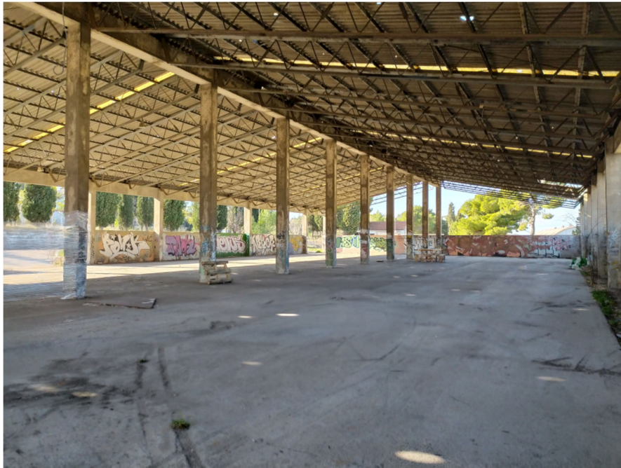
Zgrada 1 - unutarnji prostor
