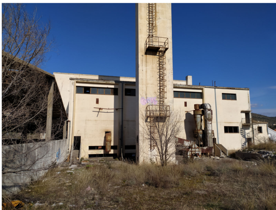
Zgrada 2 - južno pročelje s dimnjakom
